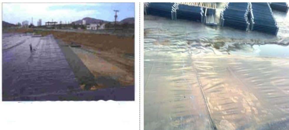
Figura 4 - Aplicação da geomembrana no tanque de aeração (lagoa)
