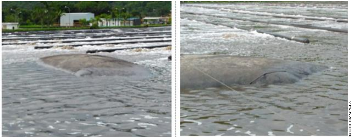
Figura 6 - Formação de bolhas no interior do tanque de aeração
