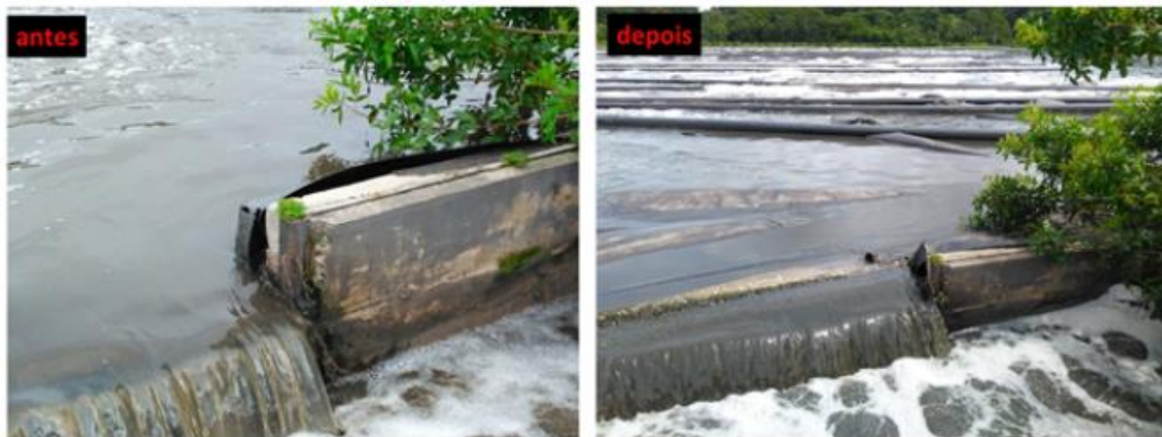
Figura 7 - Visão parcial do vertedouro de saída e descolamento da manta
