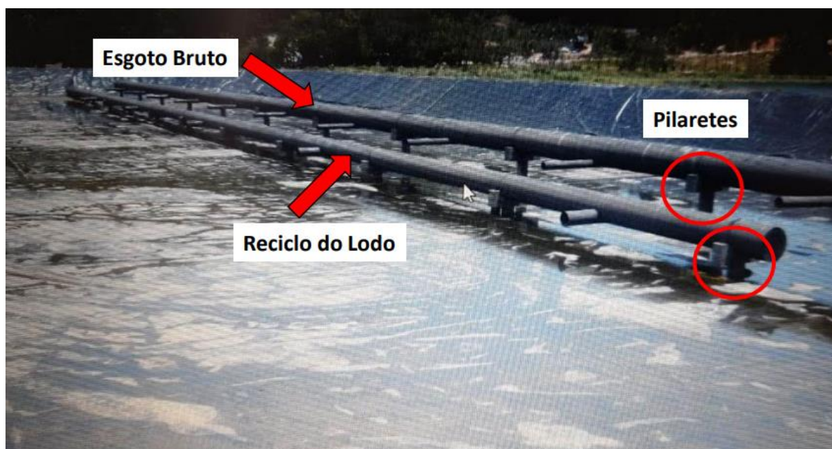
Figura 9 - Vista parcial das tubulações inseridas dentro do tanque de aeração
