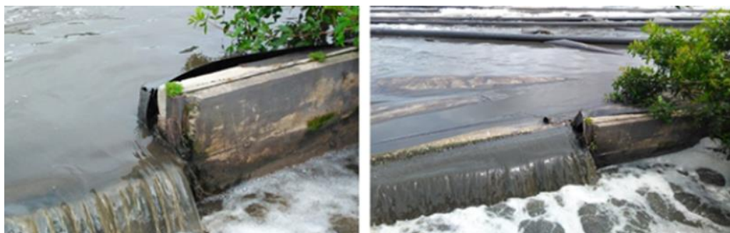
Figura 17 - Vertedor de saída do tanque de aeração
