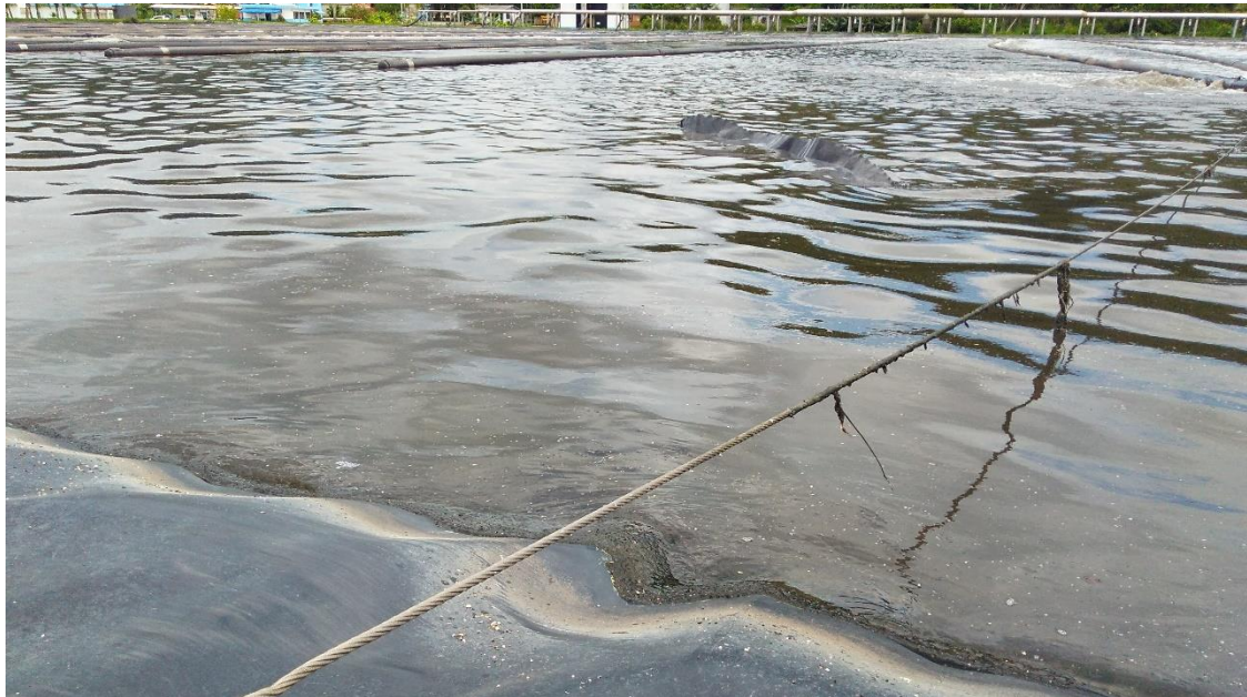
Figura 5 - Flutuação na geomembrana do tanque de aeração
